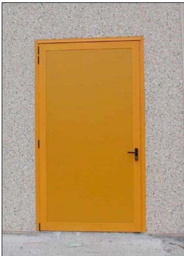
Porta costituita da pannello dello spessore di 40 mm, con profili in alluminio di contenimento e telaio perimetrale di battuta di alluminio, con sede per guarnizioni, ancorato al vano muro tramite tasselli ad espansione. Il pannello è rivestito integralmente da lamiera ottenute mediante processo di laminazione continua, in acciaio zincato sistema SENDZIMIR, sp.8/10, segue la fosfatazione e la stesura di primer dello spessore di 5 Micron su entrambe le facce.
